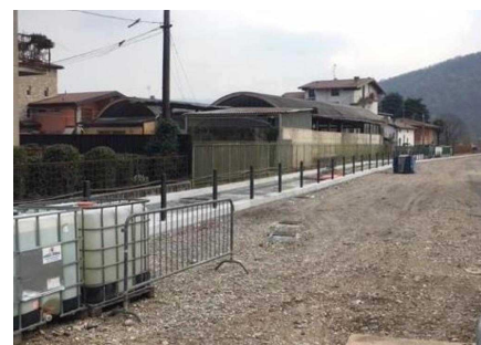
I lavori per trasformare via Zammarchi in una strada a doppio senso
