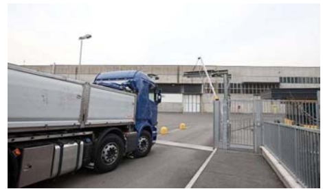
Concesio: l'esterno della fabbrica teatro dell'incidente
