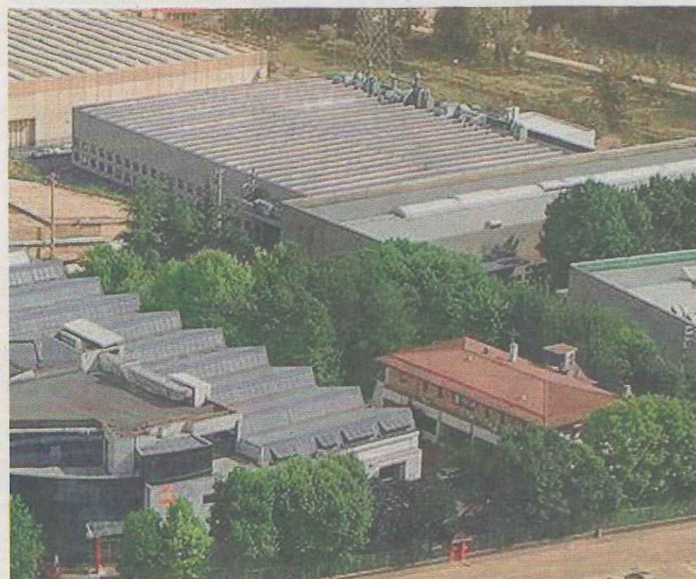
Azienda di successo. Una panoramica della Metal Work Pneumatic di Concesio
