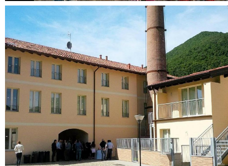
Il taglio del nastro dopo i lavori di recupero dell'ex filanda. Il cortile della fabbrica come si presenta oggi: conservata anche la preziosa ciminiera in mattoni
