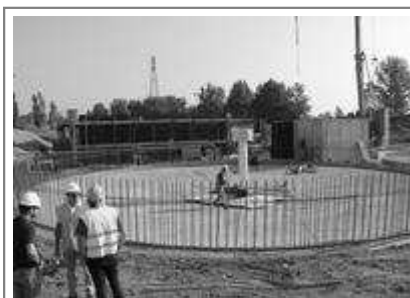
I lavori di potenziamento del depuratore di Bagnolo Mella
