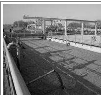
Il depuratore di Verziano, sul quale è stato effettuato un intervento da 6 milioni di euro SERVIZIO FOTOLIVE
