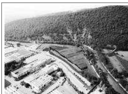
L'area di Dosso Boscone sulla quale sorgerà il depuratore di Valle
