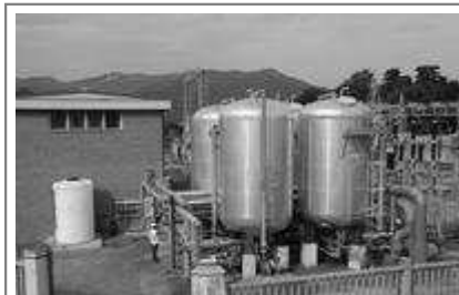
L'abbattitore di cromo esavalente di A2A già in funzione a Brescia
