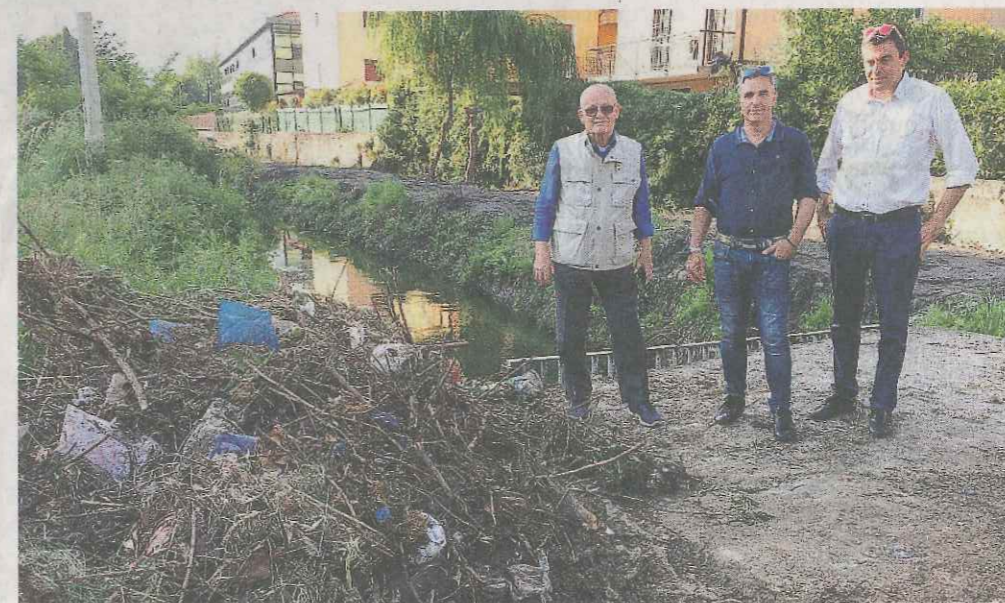
La denuncia. Da anni i residenti attendono la copertura del canale in preda all'incuria
