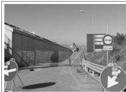
Uno degli svincoli sul raccordo Brebemi di Travagliato
