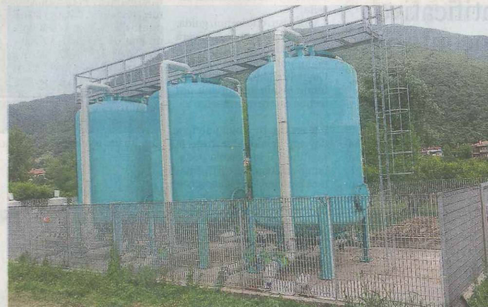
Villa Carcina. L'impianto di potabilizzazione dei pozzi LMI e Caroli dove sarà realizzato il trattamento del Cromo VI
