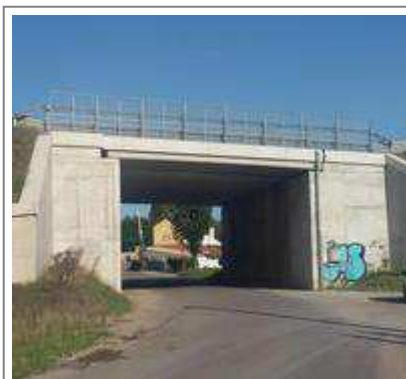
Il piccolo ma strategico sovrappasso su via Cavezzo a Castegnato
