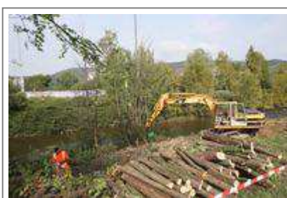
I lavori già iniziati per garantire la sicurezza e la pulizia delle sponde del Mella lungo gli argini cittadini
