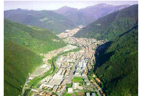
Verso l'ennesimo bivio dell'Autostrada della Valtrompia
