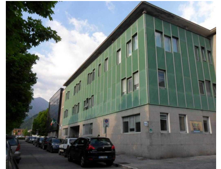
La sede della Comunità Montana di Gardone Valtrompia
