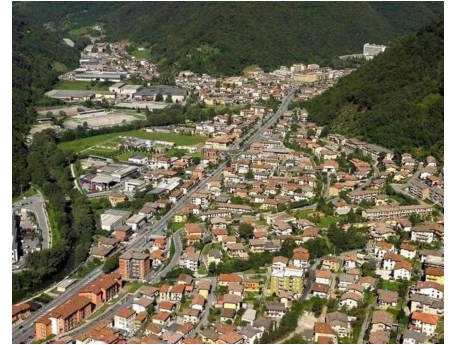
L'Autostrada della Valtrompia può attendere: altro ostacolo sulla via verso l'apertura dei cantieri
